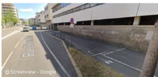
Rue Étienne Mimard : fin de liaison sur trottoir, abandonne tout espoir !
