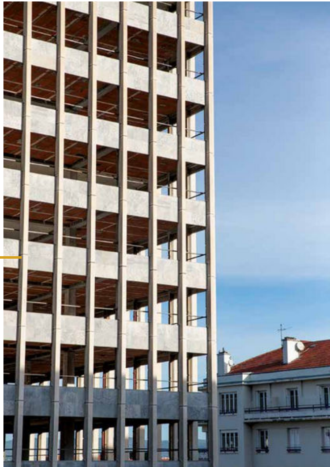
L'immeuble Loubet en cours de chantier
